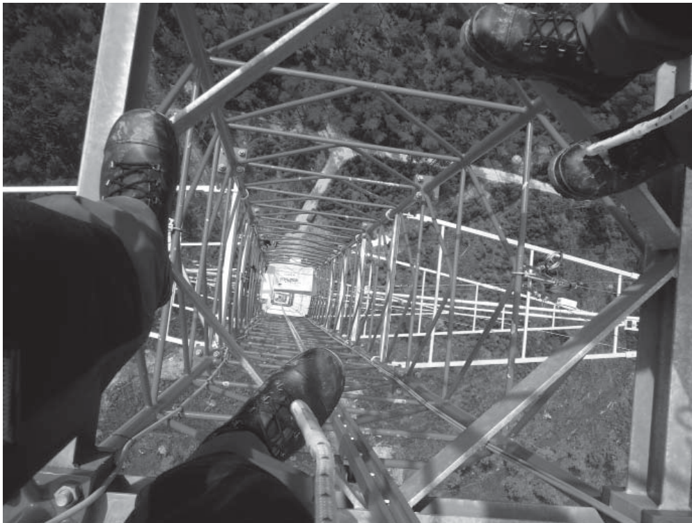
Spezialisten errichten den 200 Meter hohen Messmast. (© Fraunhofer IWES/Klaus Otto) | Bild in Farbe und Druckqualität: www.fraunhofer.de/presse
